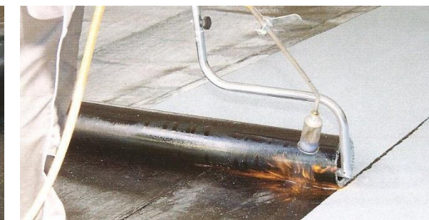
Variantní natavování s rozbalovačem rolí
